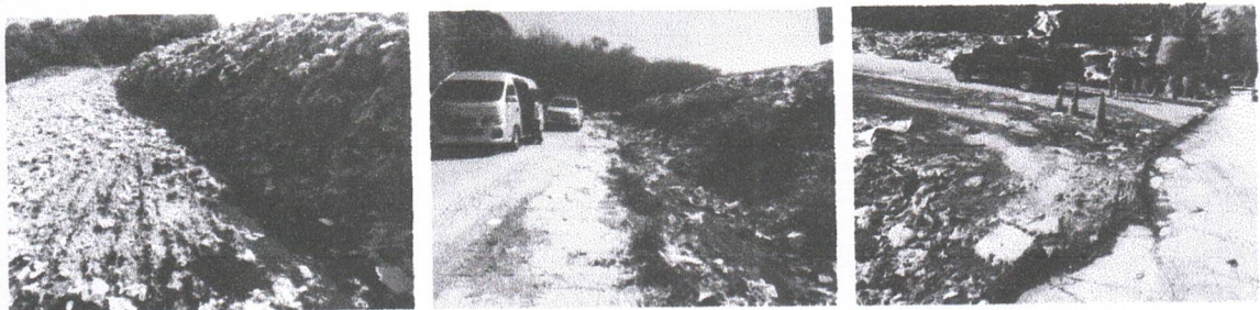
รูปที่ ๔ การไหลนองของน้ำชะขยะมูลฝอยทั้งในและรอบบริเวณสถานที่กำจัดขยะมูลฝอย ของเทศบาลตำบลบ้านดู่ จังหวัดเชียงราย
