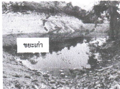
รูปที่ ๕ บ่อรวบรวมน้ำชะขยะมูลฝอยในสถานที่กำจัดขยะมูลฝอยของเทศบาลตำบลบ้านดู่ จังหวัดเชียงราย
